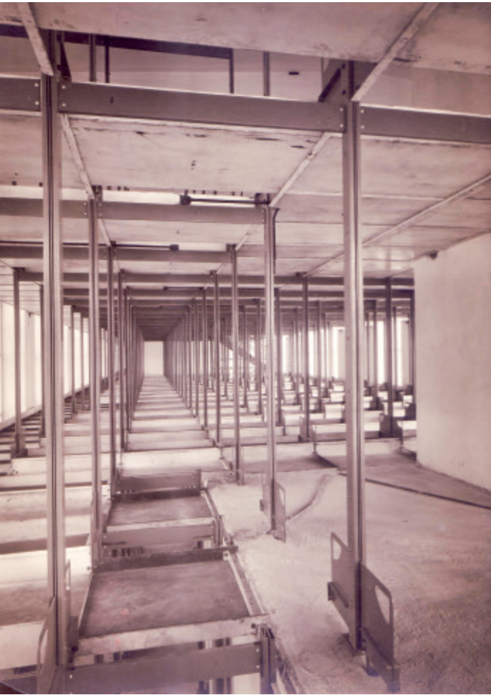
1934: Die Regale für die neue Bibliothek werden montiert.
